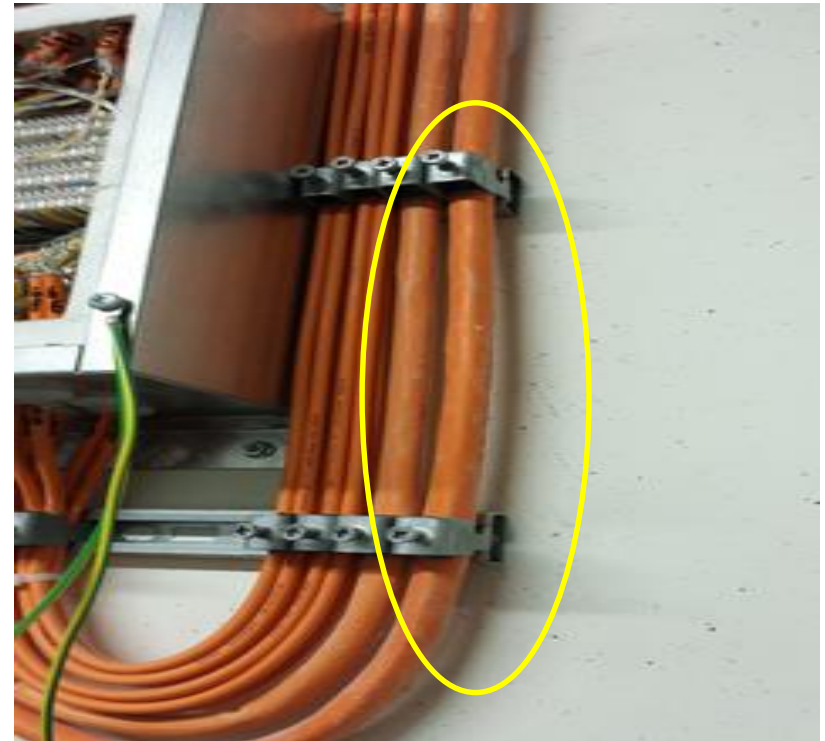
Anordnung von Bügelschellen außerhalb der Dübelbefestigung
