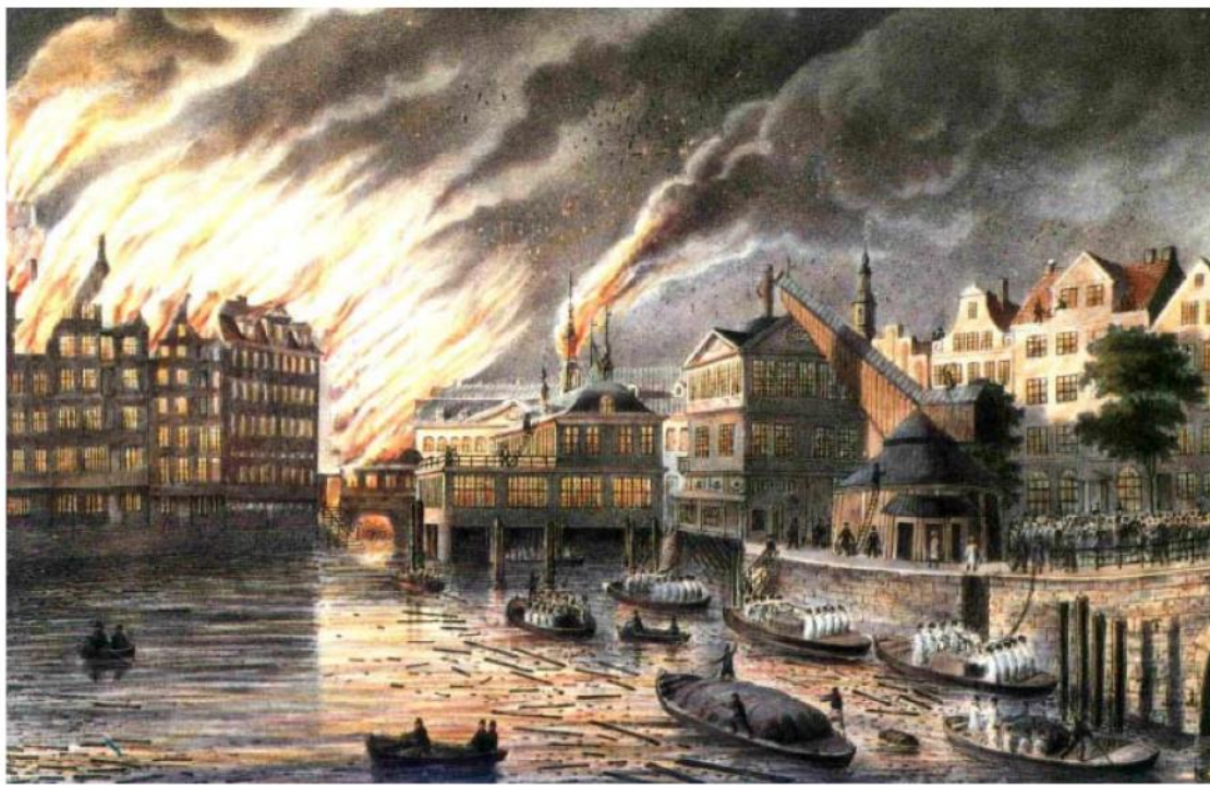
Das Nicolaifleet vom hellen Feuerschein erleuchtet. Die Spritzenmannschaften auf den Schiffsspritzen pumpen das Wasser für die bereitstehenden Feuer-Copen nach oben. In der Mitte die Börse, dahinter das alte Rathaus. Schaulustige behindern die Löscharbeiten.
