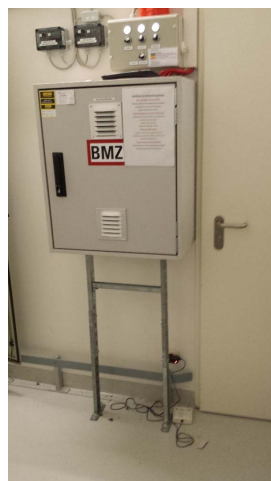
Montage von Verteilern mit Funktionserhalt an Bauteilen ohne Anforderung / Nachweis der Stützkonstruktion
