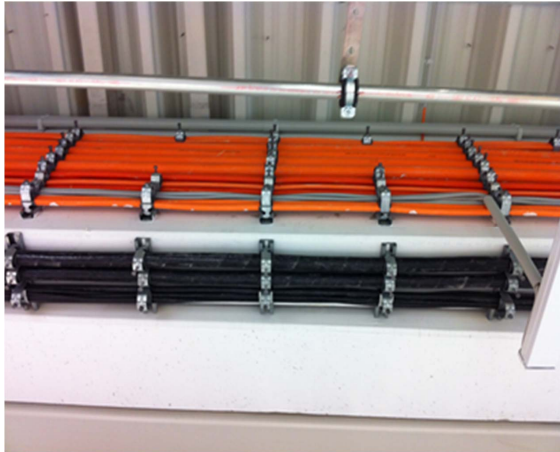
Fehlende Durchdruchtsicherung
