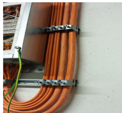
Anordnung von Bügelschellen außerhalb der Dübelbefestigung
