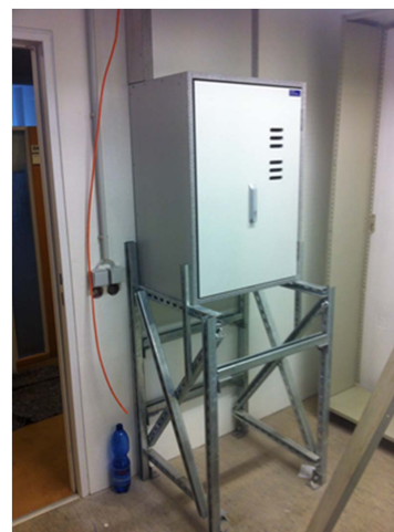
Montage von Verteilern mit Funktionserhalt an Bauteilen ohne Anforderung / Nachweis der Stützkonstruktion
