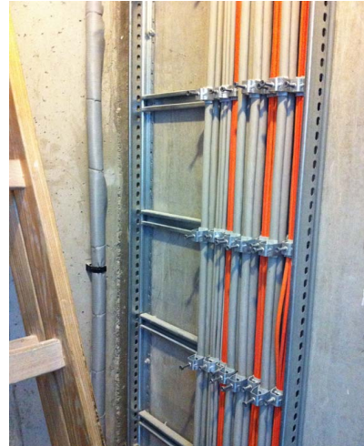
Verwendung von Bügelschellen mit Gegendruckwanne aus Kunststoff / Schellen zu fest angezogen
