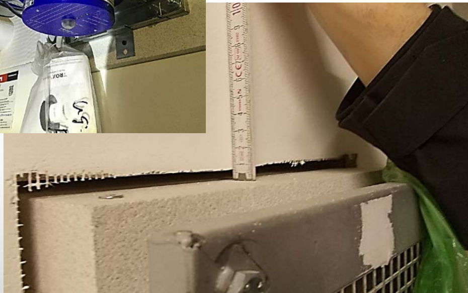
Auszug : Einbau Absperrvorrichtung mit Einbaurahmen, unzulässiger Spaltmaß
