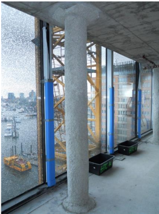
Zughänger mit Mineralfaserspritzputz
