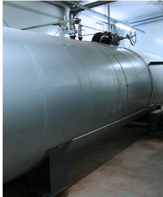
CO2-Niederdrucktank
