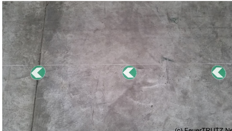
Bild 13: Fluchtleitsystem
