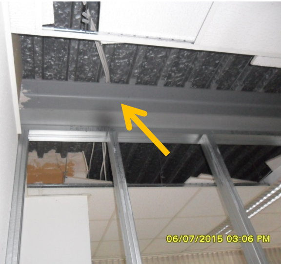
Bild 27: FO-Flurwandanschluss
