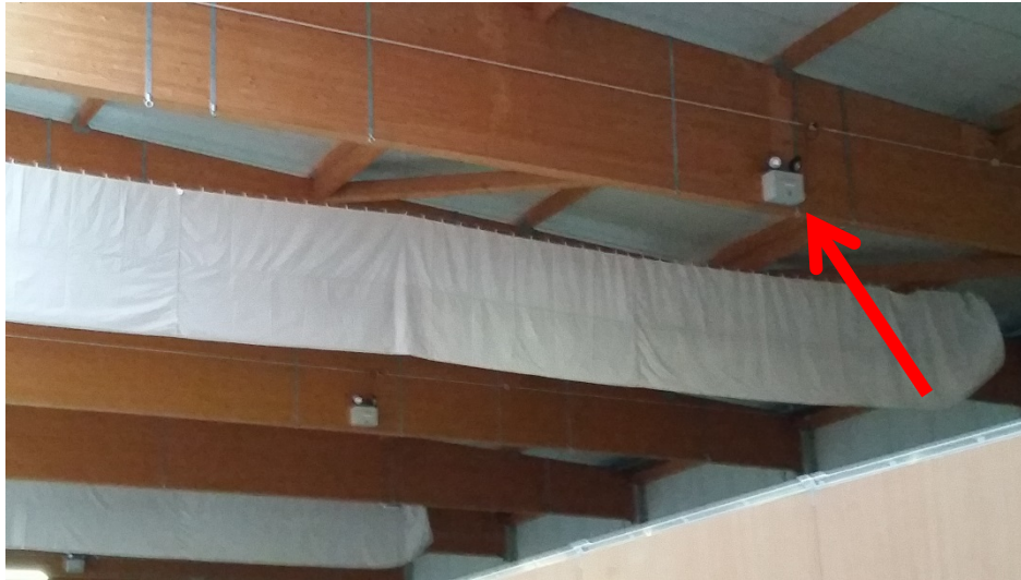
Bild 11: Warmluftverteiler / Sicherheitsbeleuchtung
