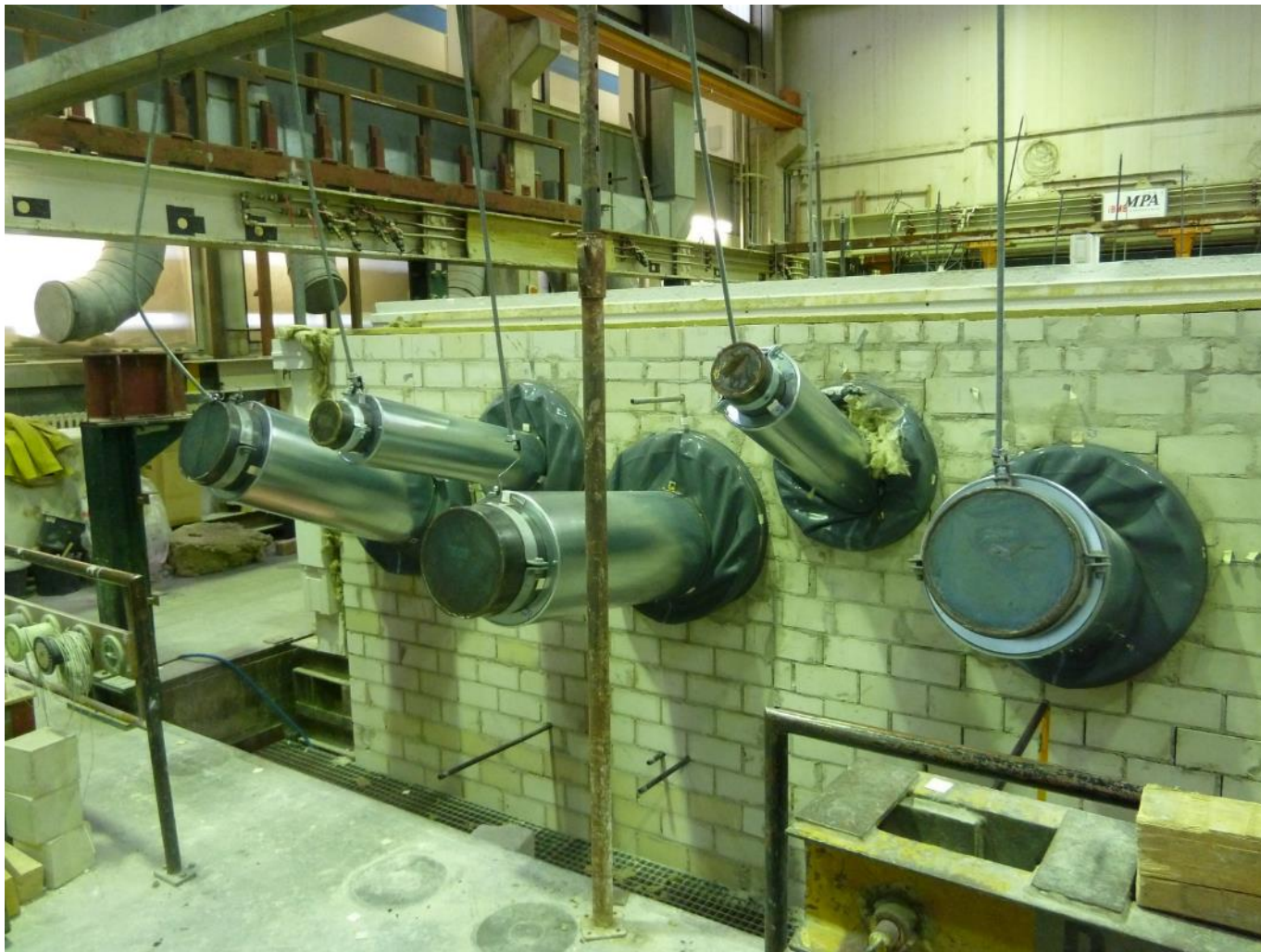
Luftseite nach dem 1. Brandversuch
