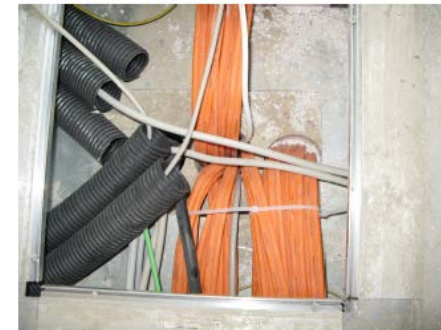
Abbildung 40: Überbelegte Kabeldurchführung in Massivdecke
