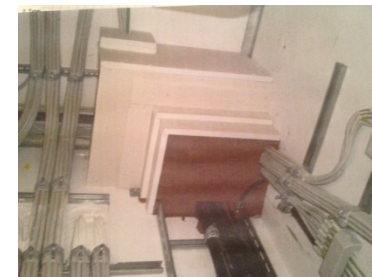
Abbildung 40: Überbelegte Kabeldurchführung in Massivdecke
