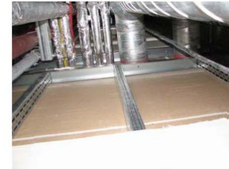
Abbildung 30: Schachtwand, 2x12,5mm, Innenseite
