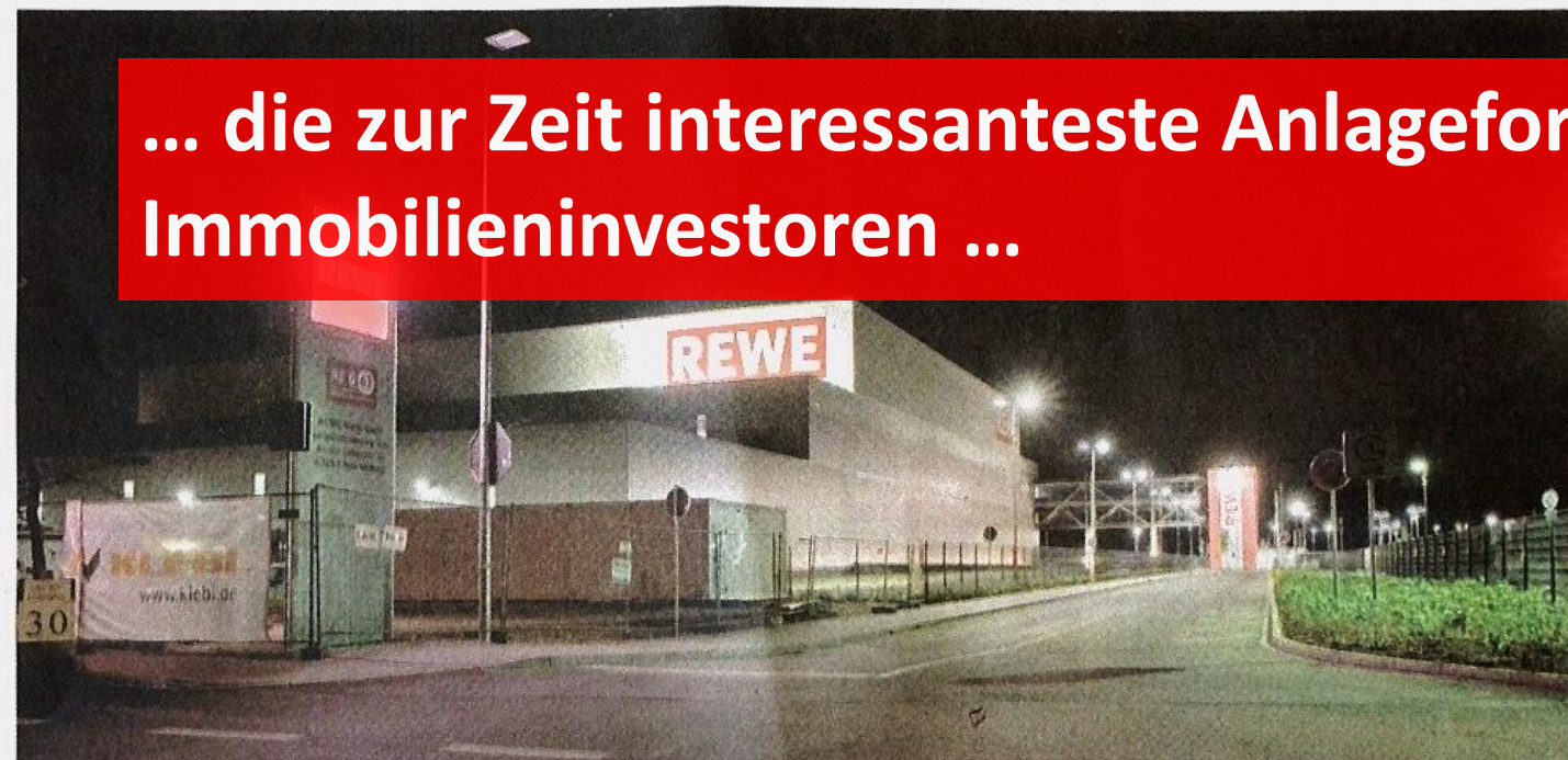
Logistische Großinvestition: Zur Belieferung seiner zahlreichen Supermärkte im Rhein-Main-Gebiet baut Rewe in Neu-Isenburg ein Zentrallager.
