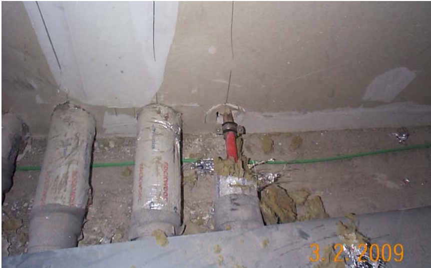
Streckendämmung vor F 90 Leichtbauwand
