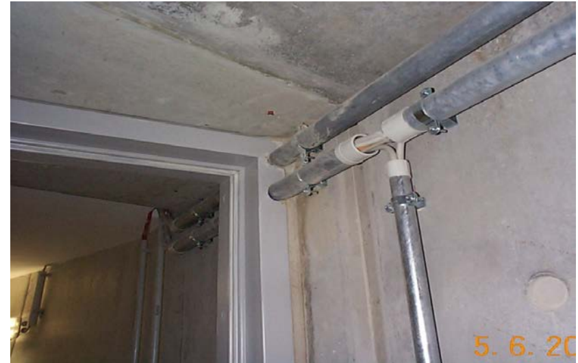
Bohrungen in einer Brandschutztür
