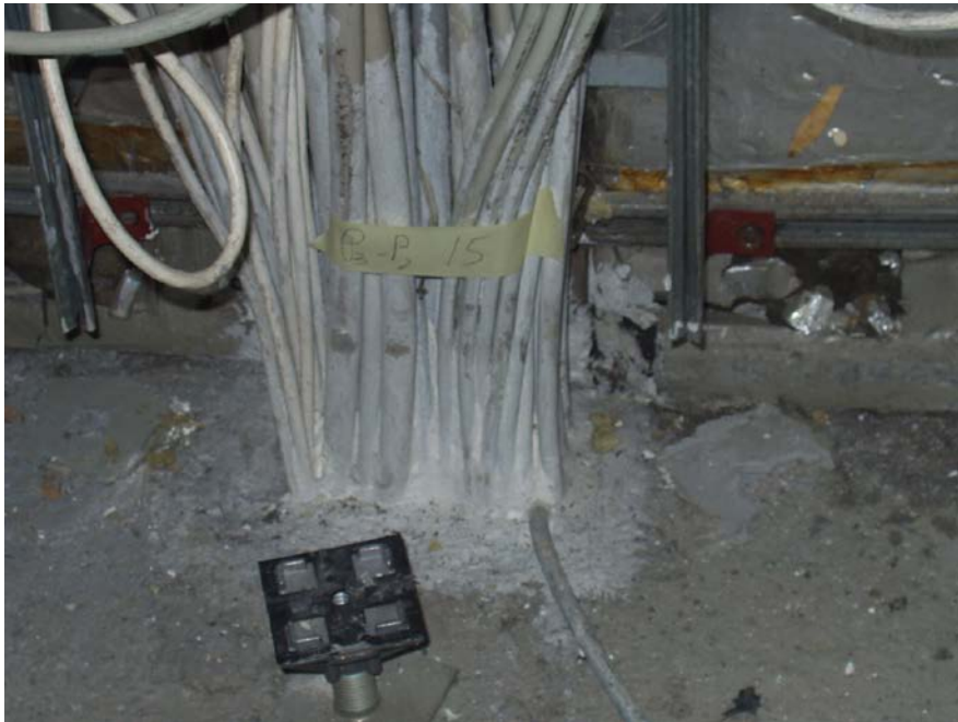
vor der Sanierung
