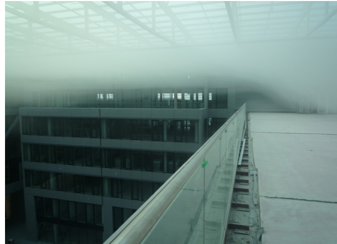
Nebel-Schichtung im Bereich der maschinellen Abluftgeräte
