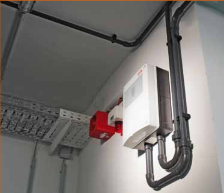
Abb. 1: Beispiel eines Ansaugrauchmelders mit Rohrsystem, das die Luft aus den überwachten Räumen ansaugt
