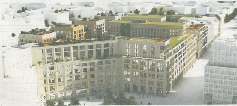
Die Mail of Berlin, künftig größtes Einkaufszentrum der Bundeshauptstadt, wird auch über eine digitale Gebäudefunkanlage verfügen. Bild: HGB
