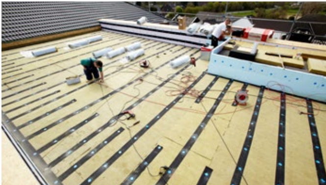
Auch die angrenzenden Flachdächer des Komplexes wurden bei der umfangreichen Sanierung brandschutztechnisch aufgerüstet
