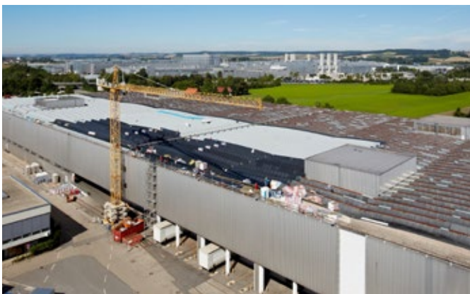
Fertigungs- und Lagerhallen BMW Dingolfing
