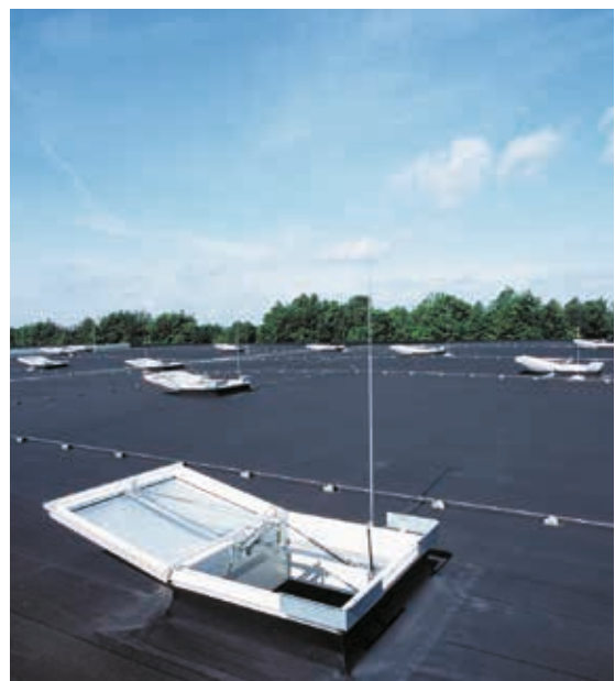
Im Dach eingebautes, qualifiziertes, natürliches Rauchabzugsgerät NRW
