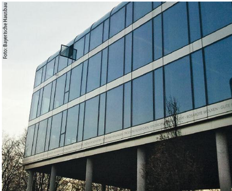
Abb. 4: Anleiterbares Fenster im Campusgebäude (Quelle: Bayerische Hausbau)
