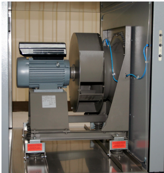
Abb. 5 a und b: Antriebe von Lüftungsanlagen
