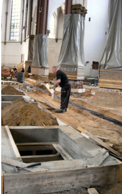
Abb. 5: Der Innenraum während der Umbauphase. (Foto: Schleiff Denkmalentwicklung)
