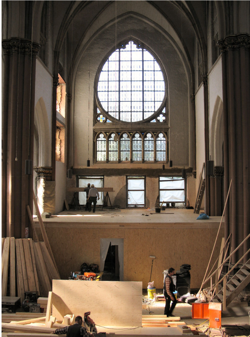
Abb. 3: Aufbau der Holzrahmenkonstruktion im Kirchenschiff Foto: Guido Franken
