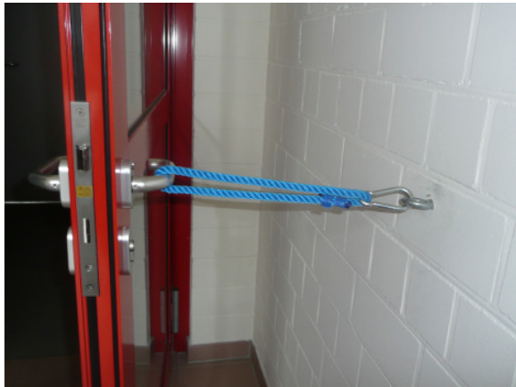
Abb. 2: Real, denn der Rettungsweg ist bei diesem Beispiel gefährdet
