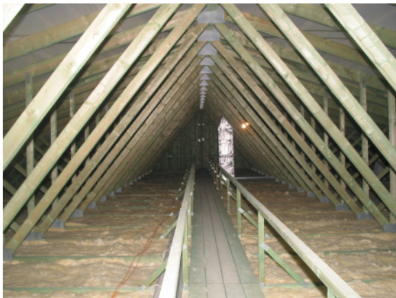
Abb. 2: Blick in den Dachstuhl einer Dachkonstruktion mit Nagelplattenbindern
