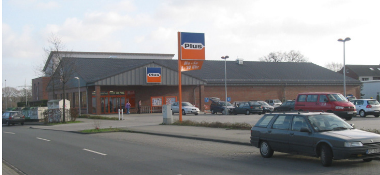
Abb. 3: Discountmarkt in typischer Bauweise mit Nagelplattenbinderkonstruktion
