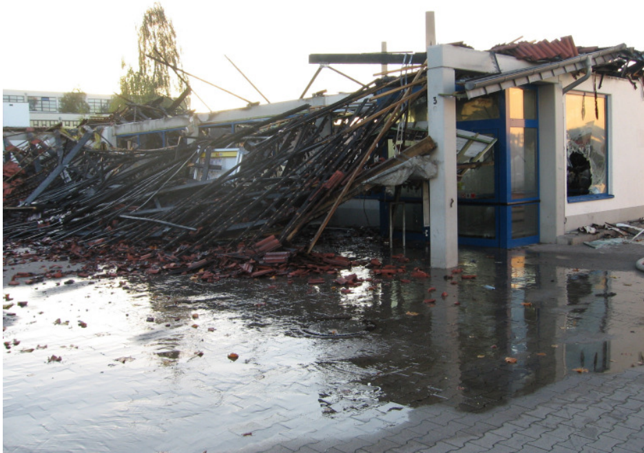
Abb. 1: Zugangsöffnung des Angriffstrupps der Feuerwehr Krefeld
