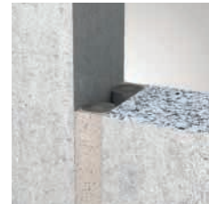
ZZ-Brandschutzsilikon NE Dehn- und Bewegungsfuge zweiseitig
