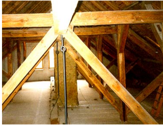
Überzug mit Stahlzugbändern im DG über einer Aula
