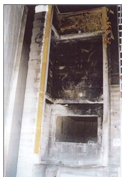
Dämmung nach dem „stripping“
