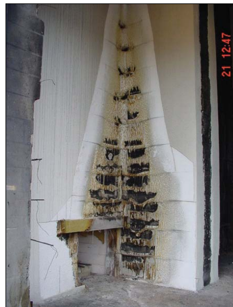
200 mm EPS 15 Putz entfernt, Dämmung
