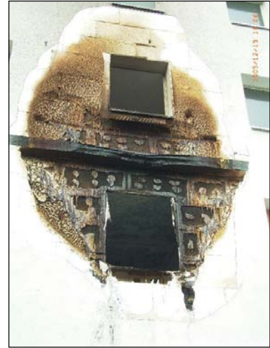
Dämmung nach dem „stripping“ PU-Brandriegel
