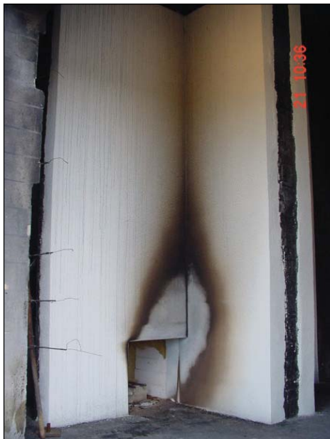
200 mm EPS 15 nach dem Versuch, Putzschicht
