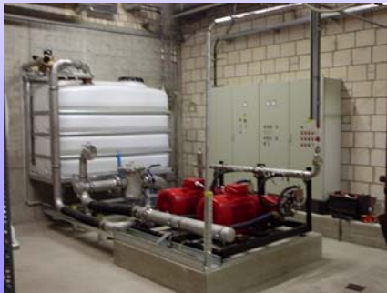
FOGTEC-Pumpeneinheit
