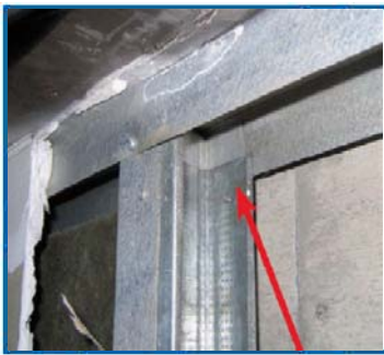
Unzulässiger Einstand \leq 15\text{ mm}
