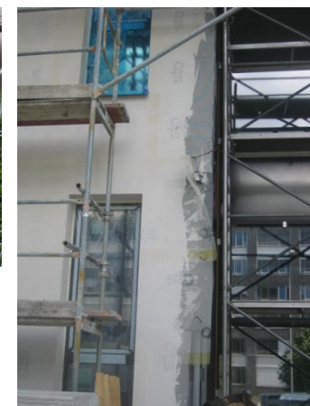
unverputzte, „offene“ Detailschlüsse am Sockel und dem Hauseingang
