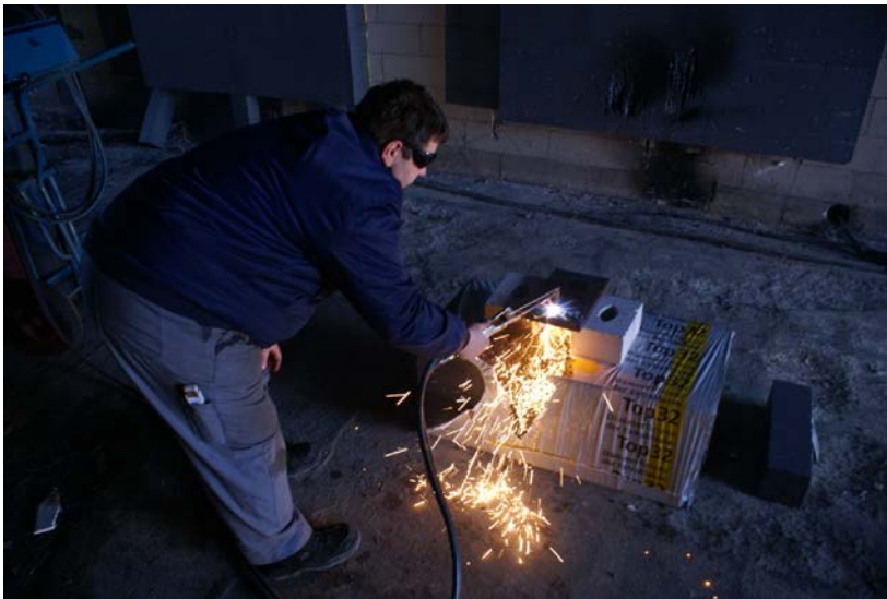
20 mm Stahlplatte durchtrennen mit Schneidbrenner
