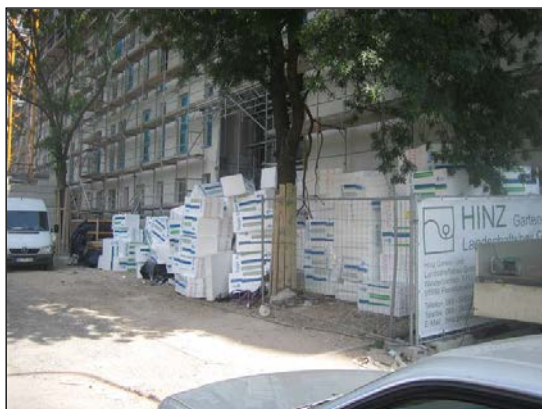
Baustelle an entgegengesetzter Ecke
