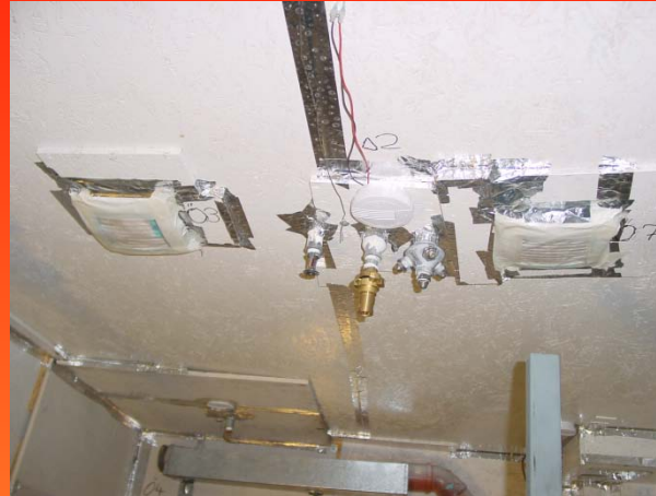
Nieder- und Hochdruck-Wassernebel-Löschdüsen
